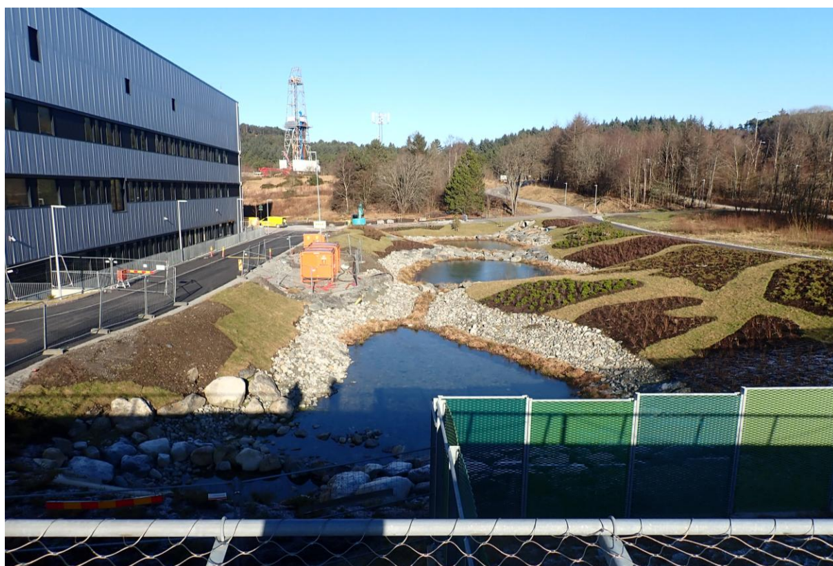
Figur 2.3. De aktuelle dammene sett fra nordre kant av helikopterlandingsplassen (12.2.2025).
